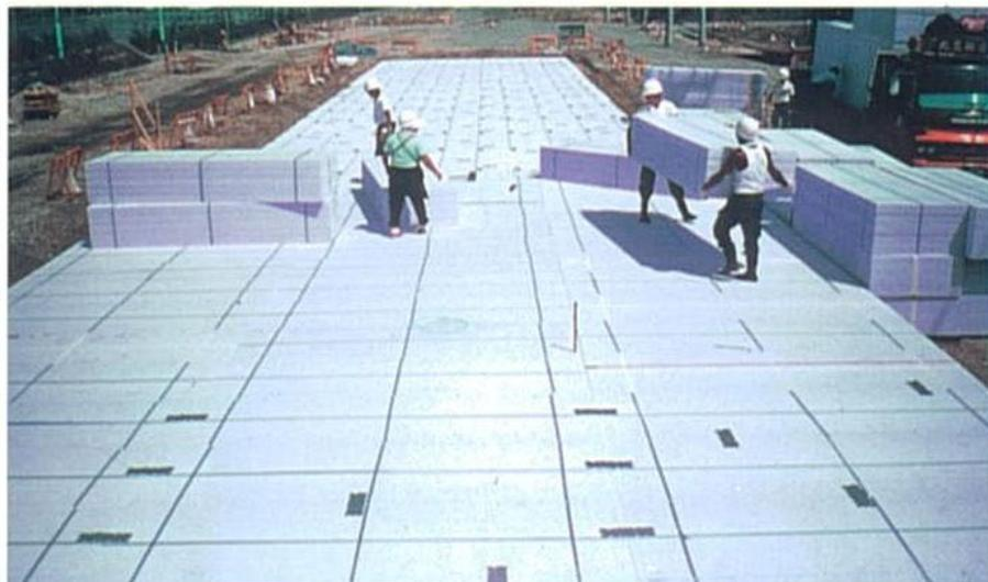
▲押出発泡法によるブロックをバンド掛けして運搬
