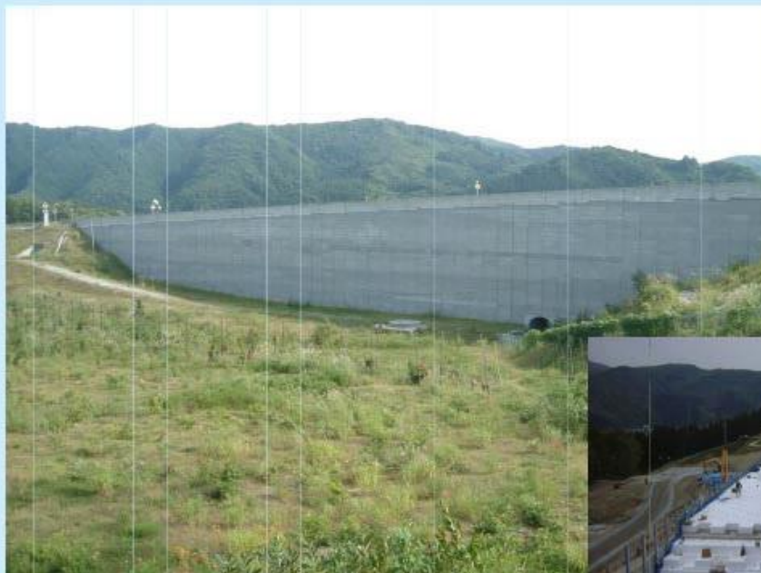
崩場地之填土 在原有供用EPS填土上再加EPS填土拓寬
