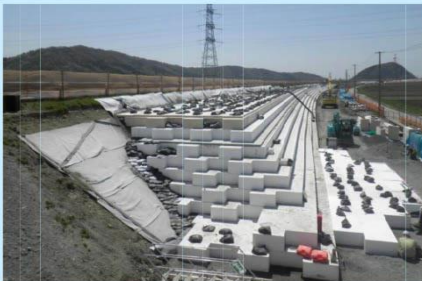
原2車道高速公路採用EPS工法擴增為4車道
