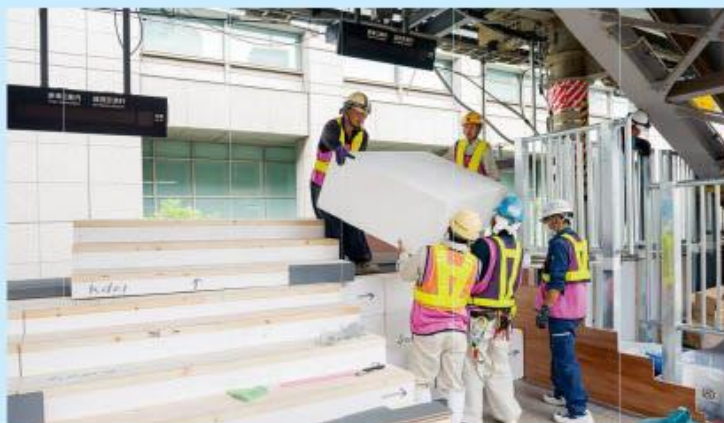
鐵路站月台提高工程 使用578個EPS板塊。形狀及尺寸都不一樣。 出典：日本經濟新聞電子版（2018年9月12日）
