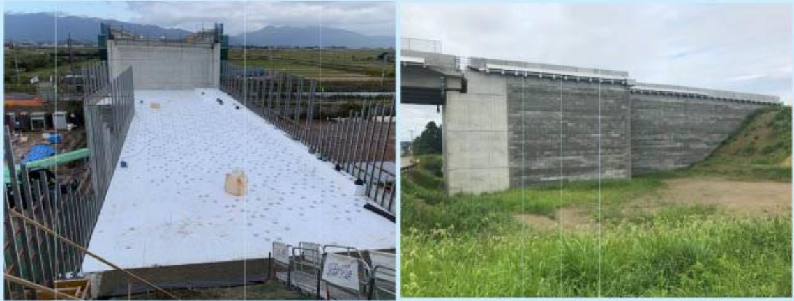
橋台背面近沉區填土 鐵路跨線橋 → 側面移動對策
