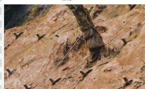
圖3 樹木保護調整承壓板位置閃避樹木，必要時增加承壓板
