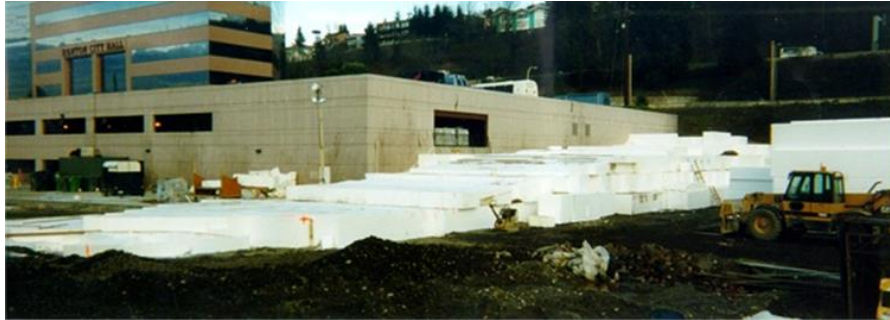
圖 2.17 華盛頓州 Renton City Hall 新建工程
