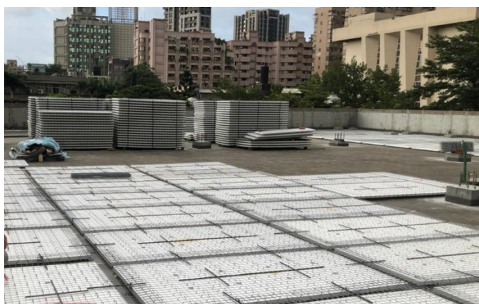
圖 2.23 國立臺北科技大學圖書館屋頂太陽能設備暨休憩空間整建工程
