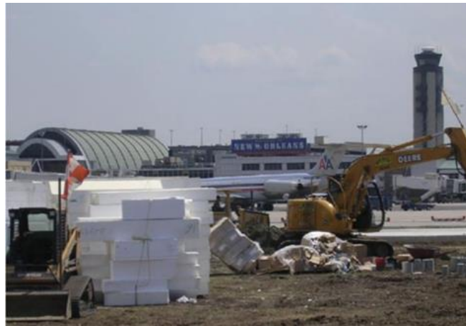
圖 2.19 新奧爾良機場東西向跑道整建工程（ACH Foam Technologies，2006）
