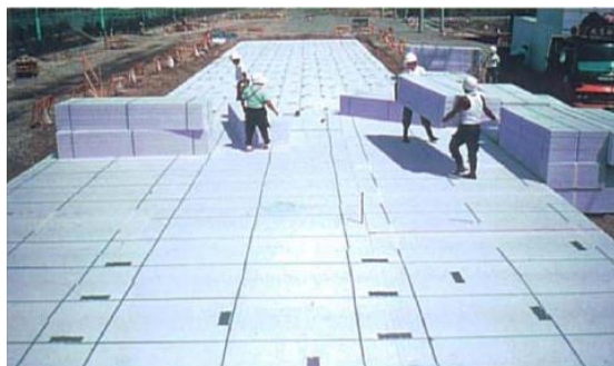
圖 2.14 北海道札幌市橋梁橋台之背填工程
