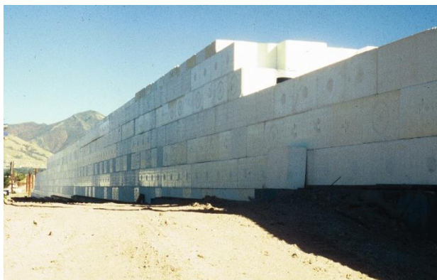
圖 2.15 猶他州鹽湖城 I-15 州際公路重建工程
