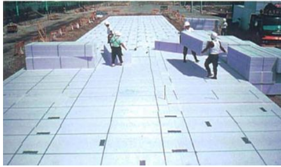
圖 2.11 北海道札幌市橋梁橋台之背填工程（積水化成品工業株式會社，2010）
