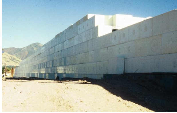
圖 2.6 猶他州鹽湖城 I-15 州際公路重建工程
