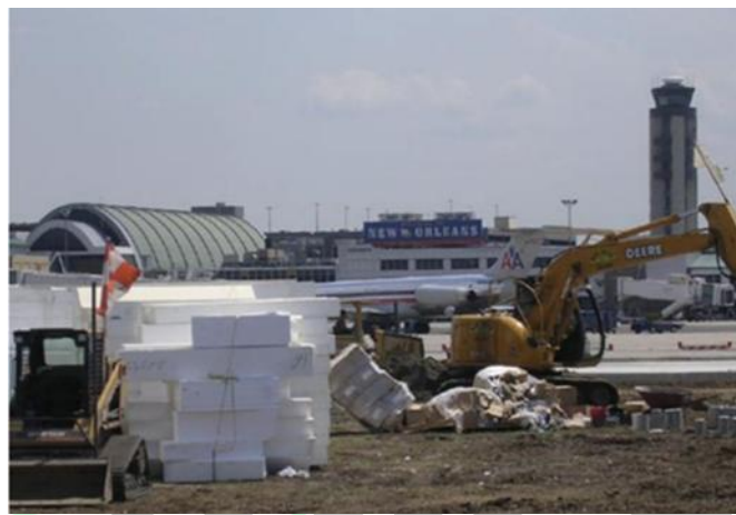
圖 2.10 新奧爾良機場東西向跑道整建工程（ACH Foam Technologies，2008）
