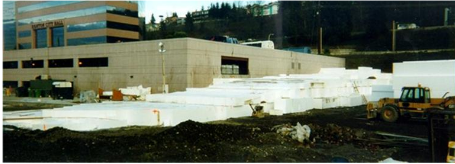
圖 2.8 華盛頓州 Renton City Hall 新建工程（Geofoam Research Center，2000）
