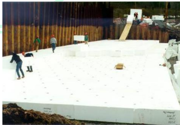
圖 2.7 紐約州厄特縣 23A 道路工程（Geofoam Research Center，2000）
