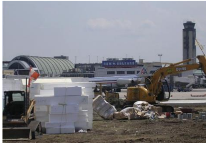
圖 2.10 新奧爾良機場東西向跑道整建工程（ACH Foam Technologies，2006）
