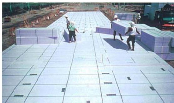
圖 2.11 北海道札幌市橋梁橋台之背填工程
