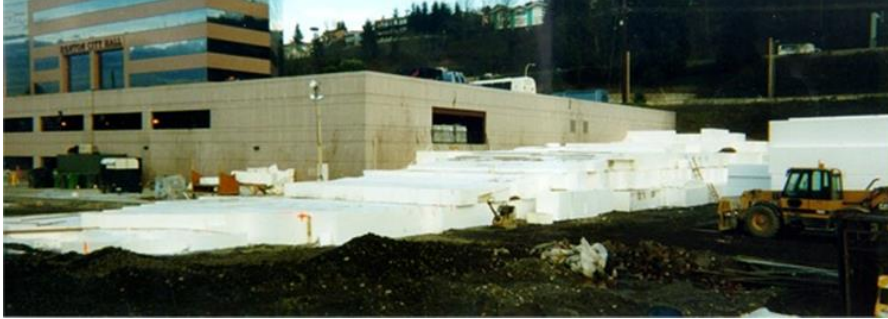
圖 2.8 華盛頓州 Renton City Hall 新建工程
