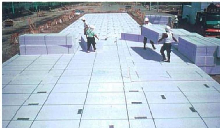
圖 2.9 北海道札幌市橋梁橋台之背填工程
