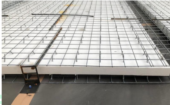
圖 2.21 EPS 及雙層點焊鋼絲網
