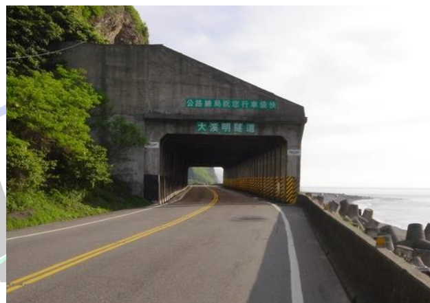
圖 2.19 台東太麻里大溪明隧道
