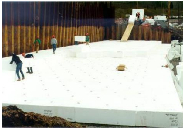
圖 2.20 紐約州厄特縣 23A 道路工程
