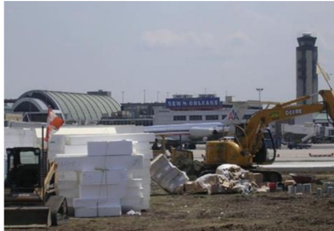
圖 2.23 新奧爾良機場東西向跑道整建工程（ACH Foam Technologies，2006）
