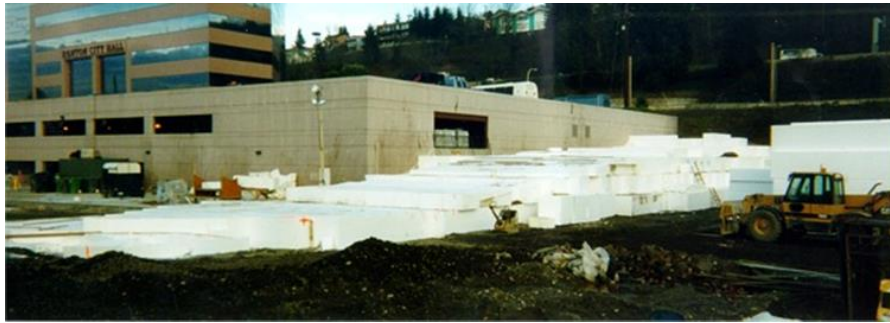
圖 2.21 華盛頓州 Renton City Hall 新建工程
