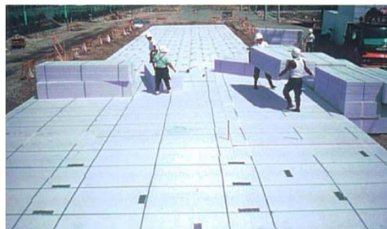
圖 2.24 北海道札幌市橋梁橋台之背填工程
