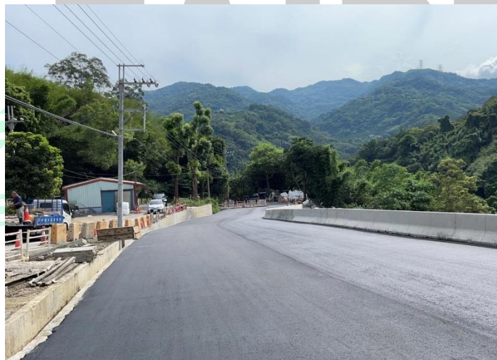
圖 2.13 三峽區北 113 縣(0K+650)災害復建工程
