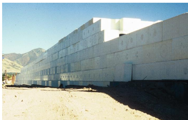
圖 2.19 猶他州鹽湖城 I-15 州際公路重建工程
